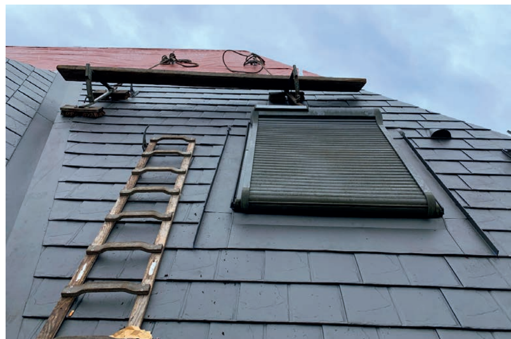
Die Verlegung der Kanada-Schindel erfolgte reihenweise von links nach rechts.
