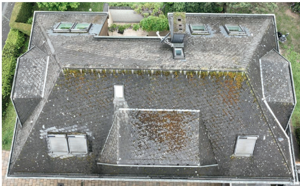
Der „Vorher-Zustand“ mit den Faserzement-Bogenschnittschindeln.
