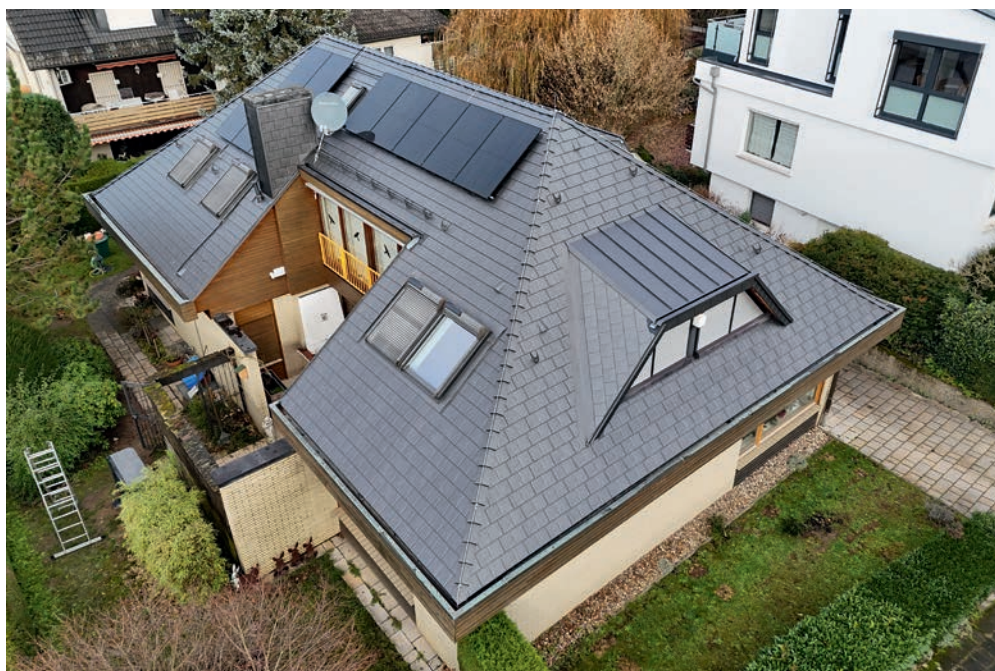
Die Wahl von Dachdeckermeister Maximilian Rohn fiel auf die Kanada-Schindel der Haushaut GmbH. Die Entscheidung basierte auf dem Dreiklang: Leicht, sturmsicher, wartungsfrei.
