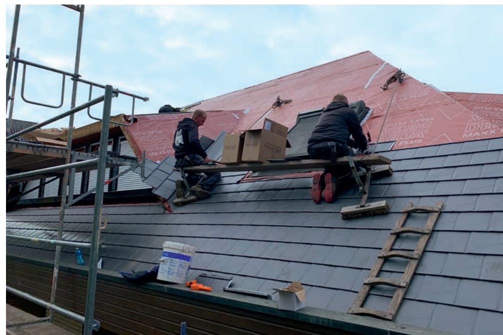
Das routinierte Rohn-Team konnte das Projekt nach nur drei Wochen abschließen.
